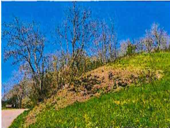
Foto 1: Offene Felsbildung im Südwesten des Plangebiets
